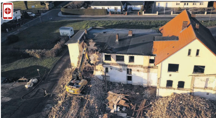
Der Abriss des ehemaligen Werkstatt- und Verwaltungsgebäudes der Wohnbau GmbH Prenzlau ist im vollen Gang. Wie Sie mit ihrem Smartphone einen Film von diesem Ereignis sehen können, erfahren Sie im unten stehenden Infokasten. FOTOS: UMTV
